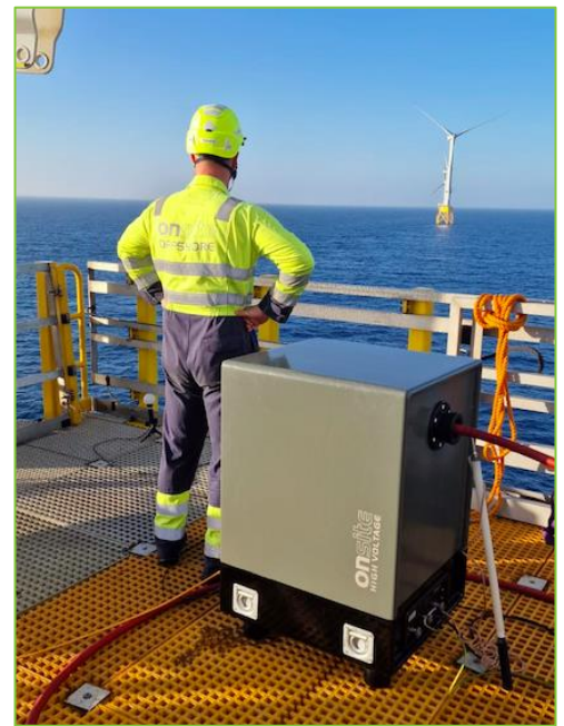
使用 DAC HV110系统测试出口电缆：主单元（带双电源）安装在陆上变电站）。远端单元安装在海上变
